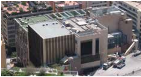
Instalacja w Monte Carlo (Monaco)
