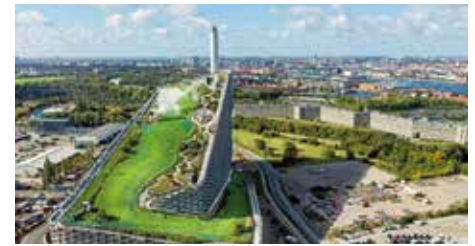
Instalacja w Kopenhadze Amager Bakke
